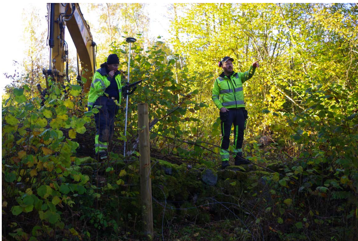
Figur 2. Arbetsbild: arkeolog Ivonne Dutra Leivas och grävmaskinist Morgan Lang står vid mur 2 och planerar inför schaktningsarbetet. Foto från norr.
