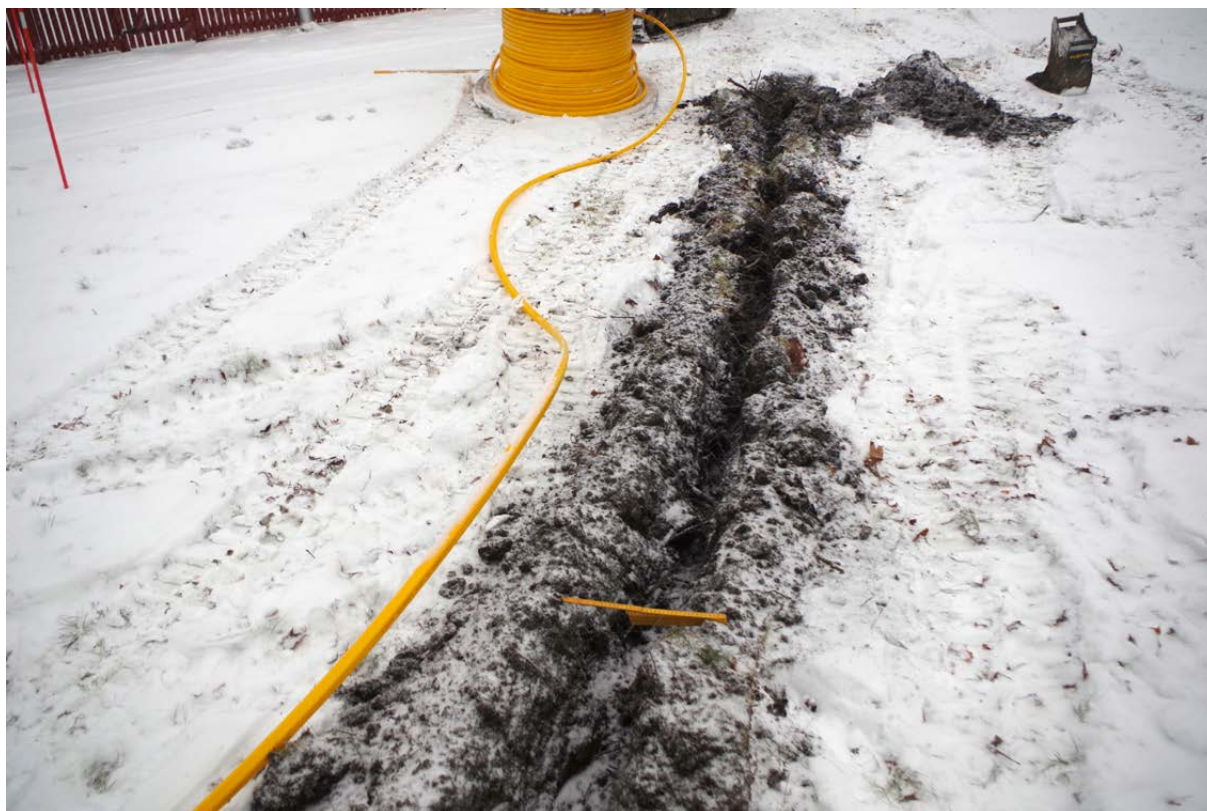
Figur 2. Upptaget kabelschakt. Foto från väster.
